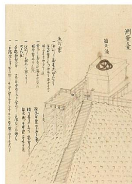
浅草天文台の簡天儀 天文台中央の築山(測量台)の上におかれた主力観測装置。天体の位置を測定するために用いられた。
