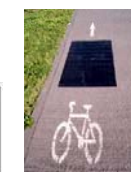
自転車交通の検知装置(Traffic Tech)
