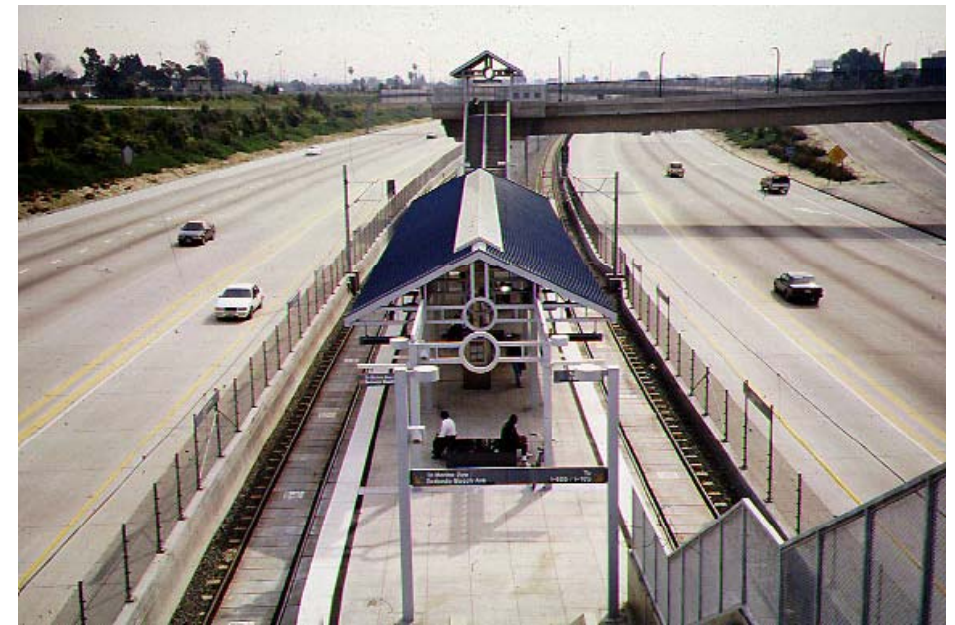
センチュリーフリーウェイ(LA) 10車線の内2車線がLRT, 2車線がHOV
