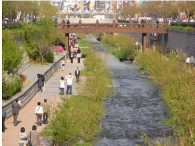
工事中と完成後のチョンゲチョン(ソウル) 都心の高架道路を撤去して環境整備を実施
