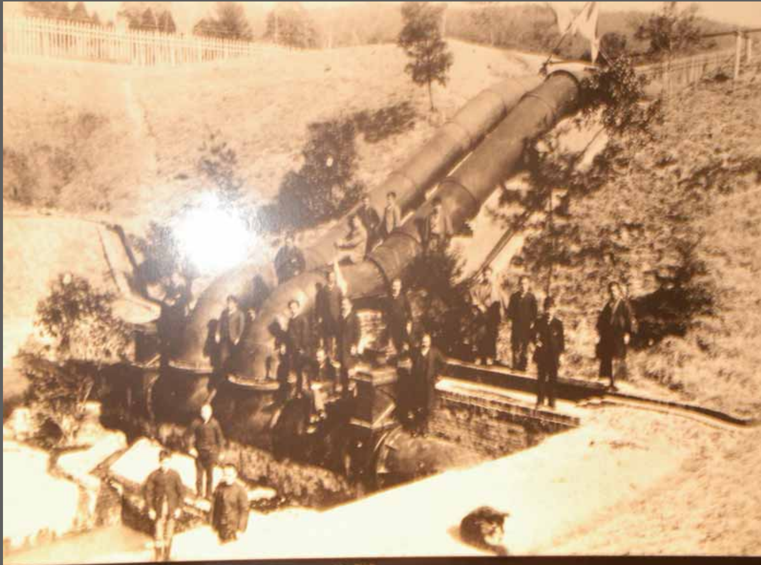
蹴上発電所の水圧鉄管 (口径90cm)
