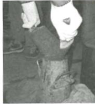
コンクリート投入
