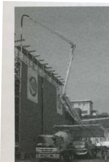
コンクリートポンプによる打込み
