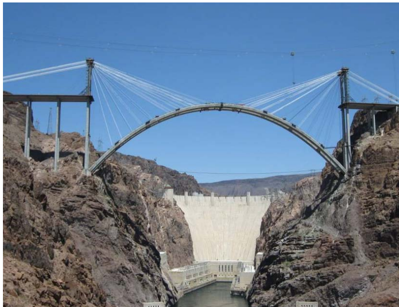
米国・フーバーダムアーチ橋 (アーチスパン = 323m)
