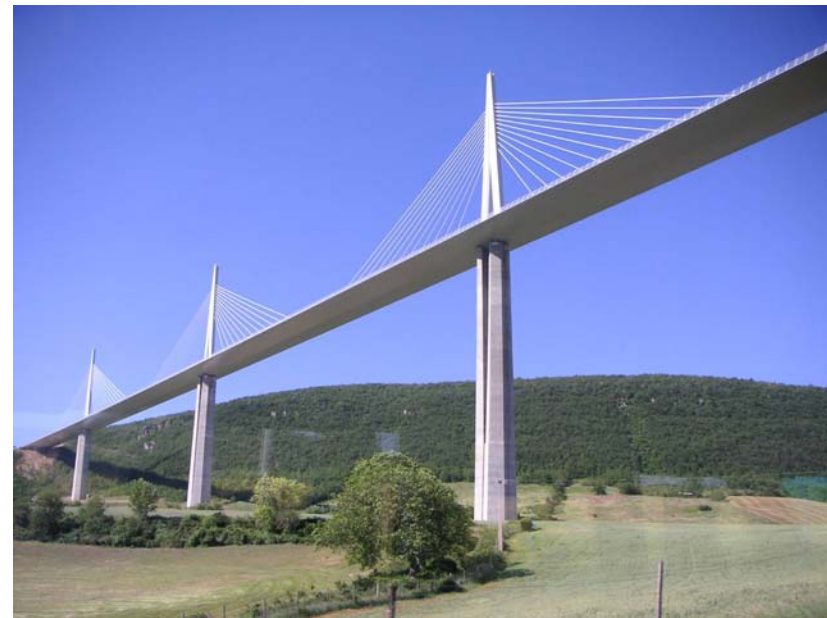
仏 ミヨー高架橋 (橋脚高さ = 245 m)
