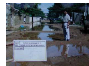
整備前のひどい状態(二輪車は走れない)
