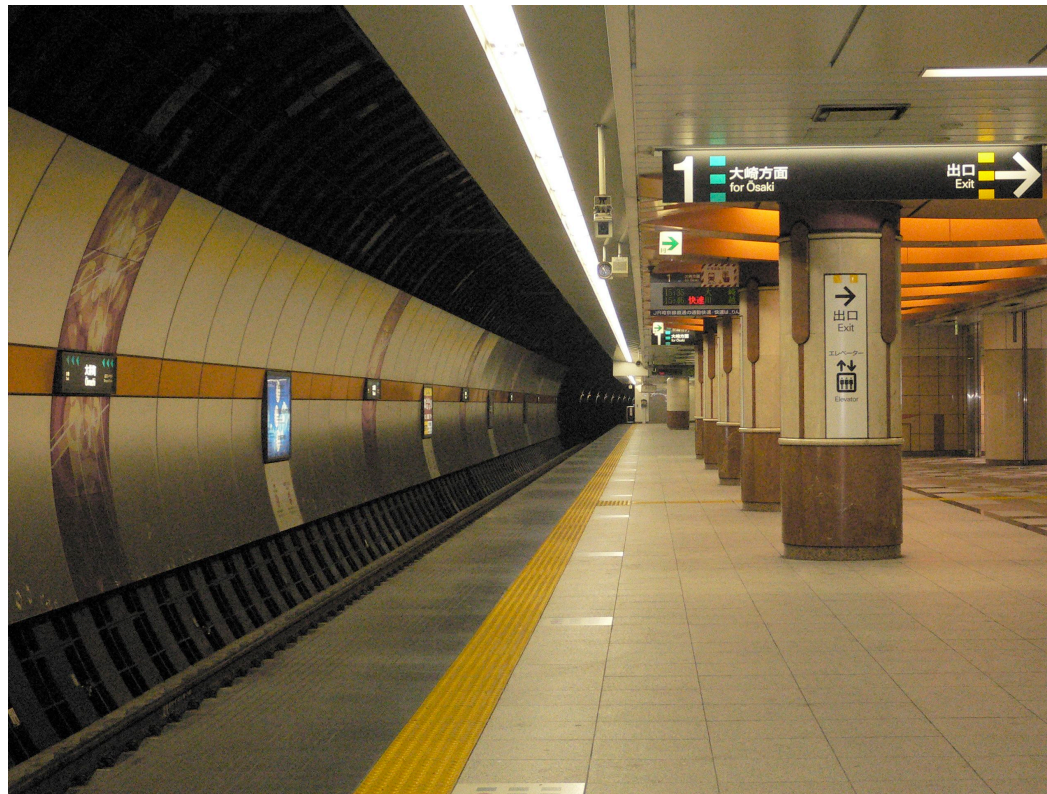
大井町地下鉄 プラットフォーム
