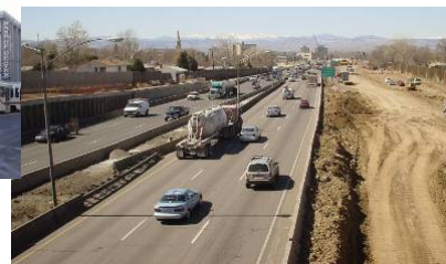
↑デンバーのLRT建設と高速道路拡幅事業 (郊外ネットワーク化)
