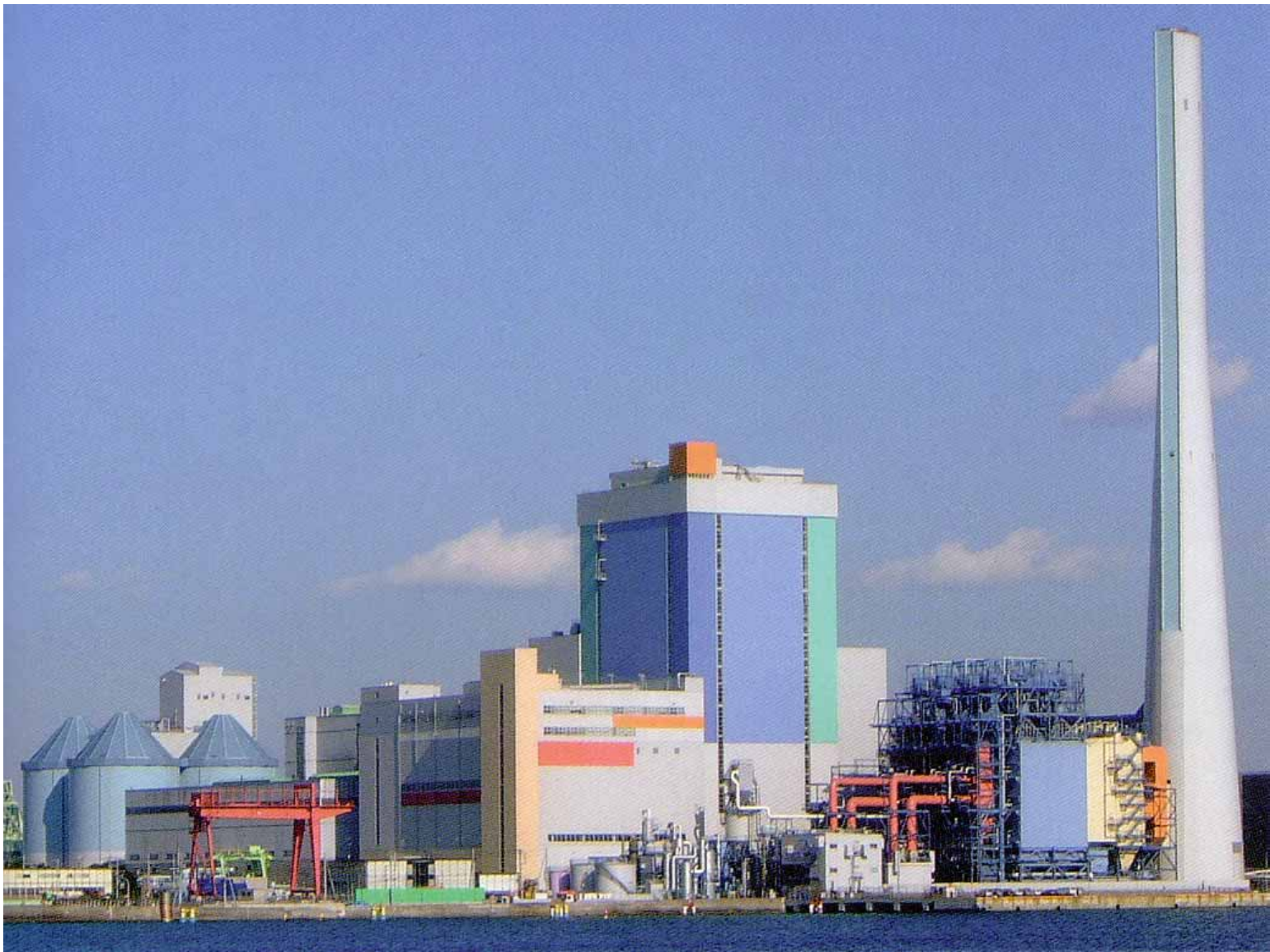
電源開発(株)礪子火力発電所
