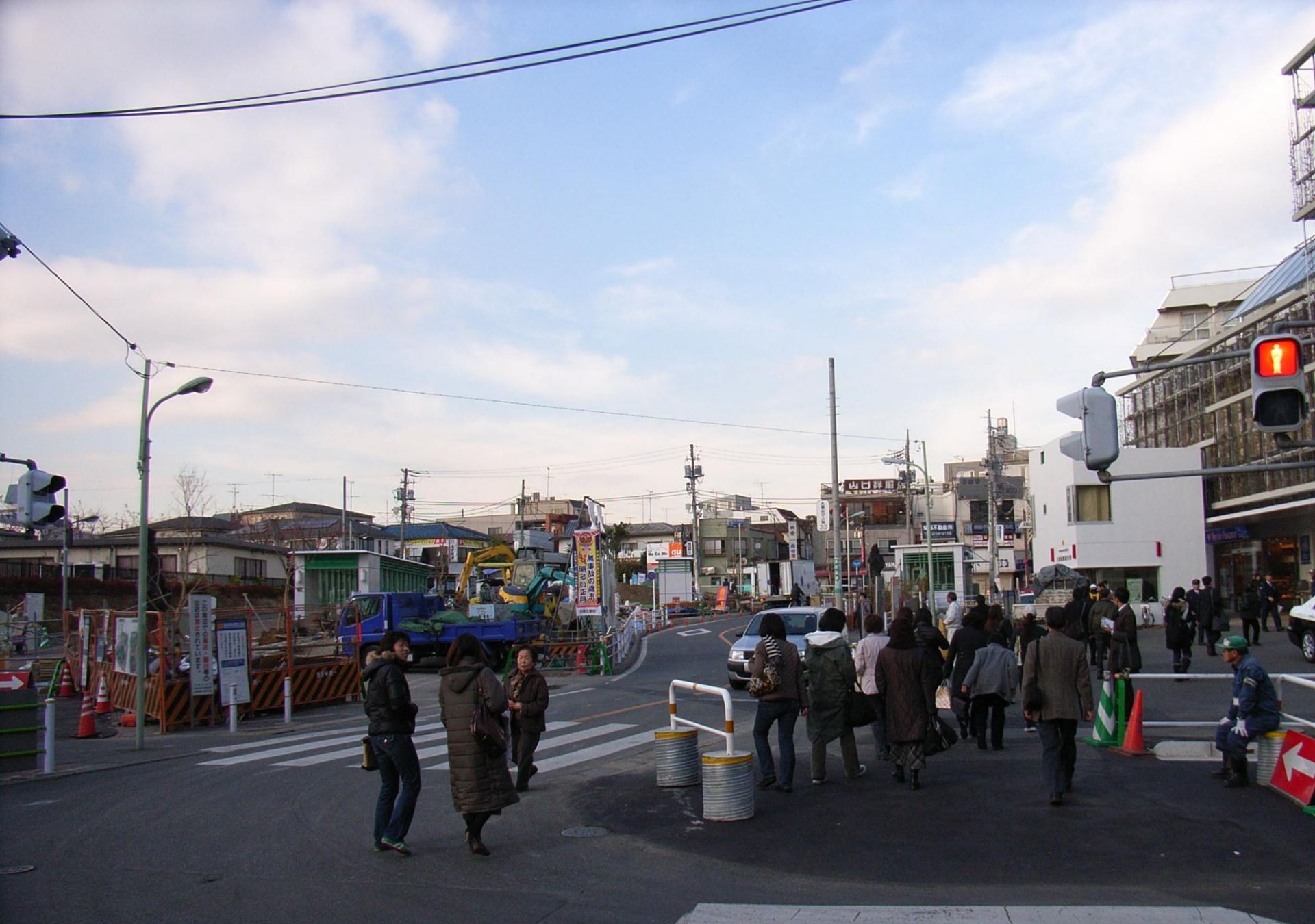
駅前広場の工事中の風景(既に地下の駐輪場は整備済み)
