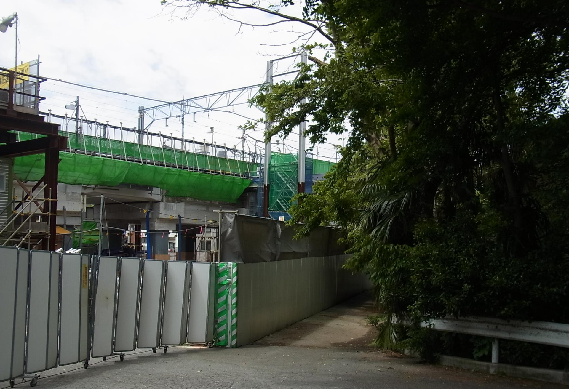
緑ヶ丘駅(改修工事中) 学内から現在の出入り口方向を撮影
