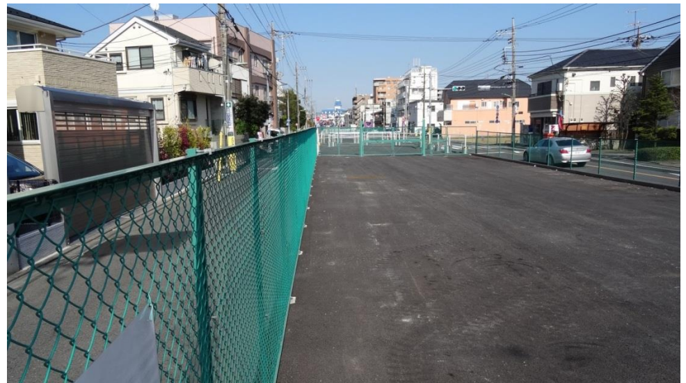
2015年頃の姿（目黒線の地上部に蓋がかかり，後は緑道の完成を待つばかり）
