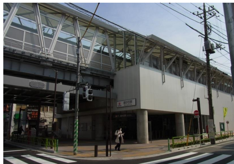
現在の緑ヶ丘駅(改札前の空間, 駐輪場等整備)
