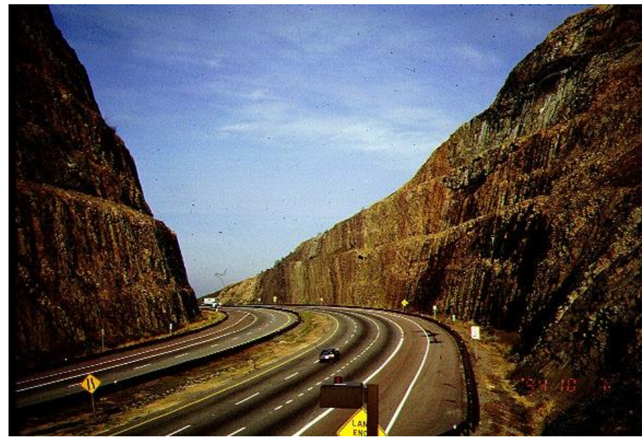
サイドリングヒル (I68, MD) 線形確保(高速化) のため山を崩した
