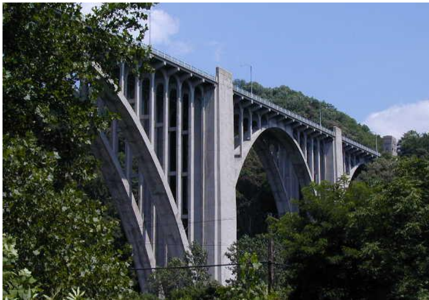
ウェスティングハウス橋 (Lincoln H, PA) 混雑緩和のために谷を越えた(1932)
