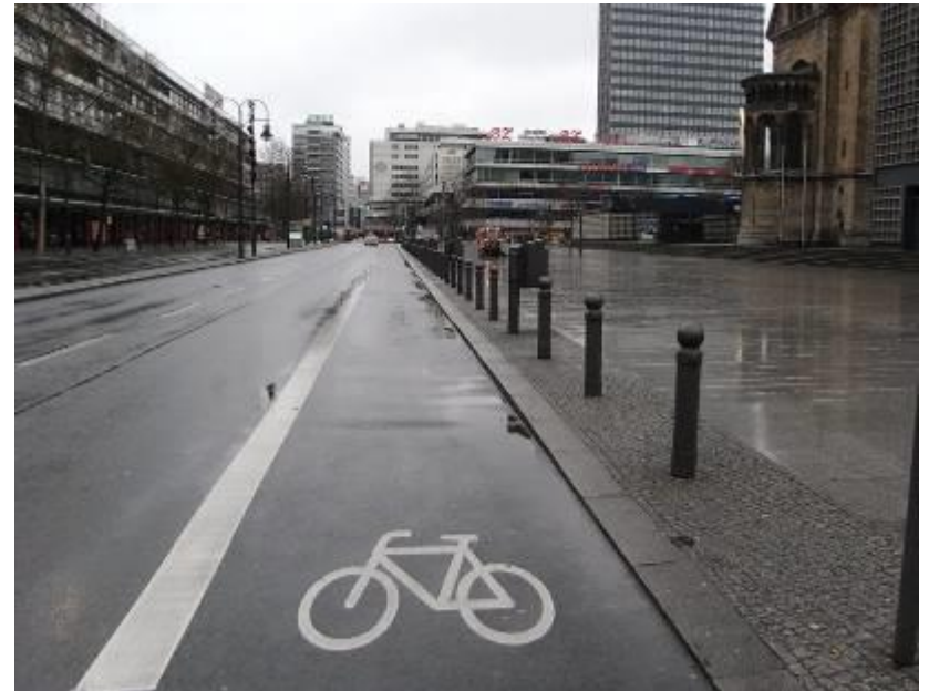
車道上の自転車レーンの整備(写真はベルリン)
