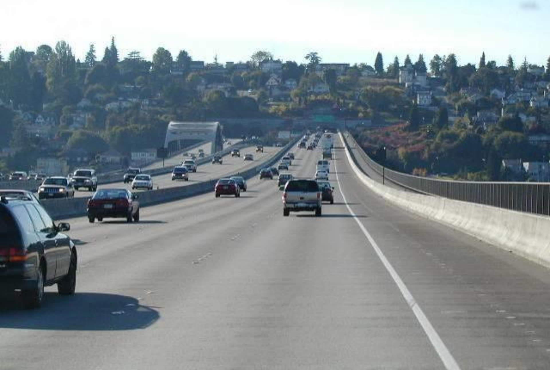
I90 フローティングブリッジでシアトル市内へ入る区間
