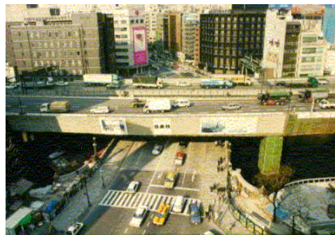
日本橋 3環状完成後には 高架道路を撤去可能か
