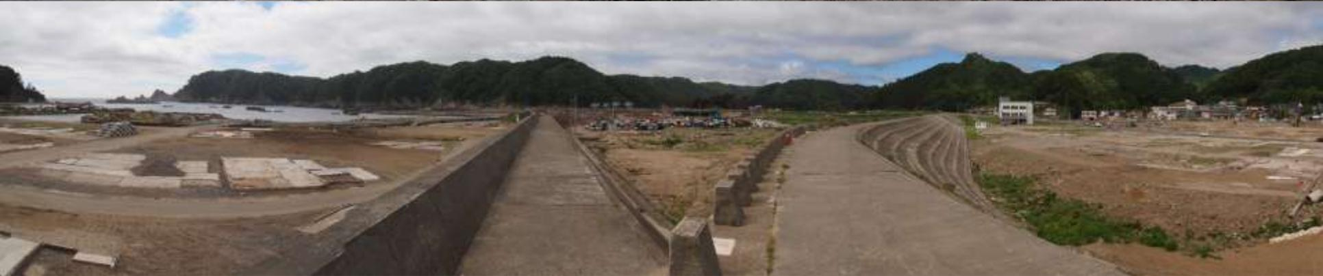
海面から10mの高さの2重の防潮堤でも止められなかった津波被害(岩手県宮古市田老地区)
