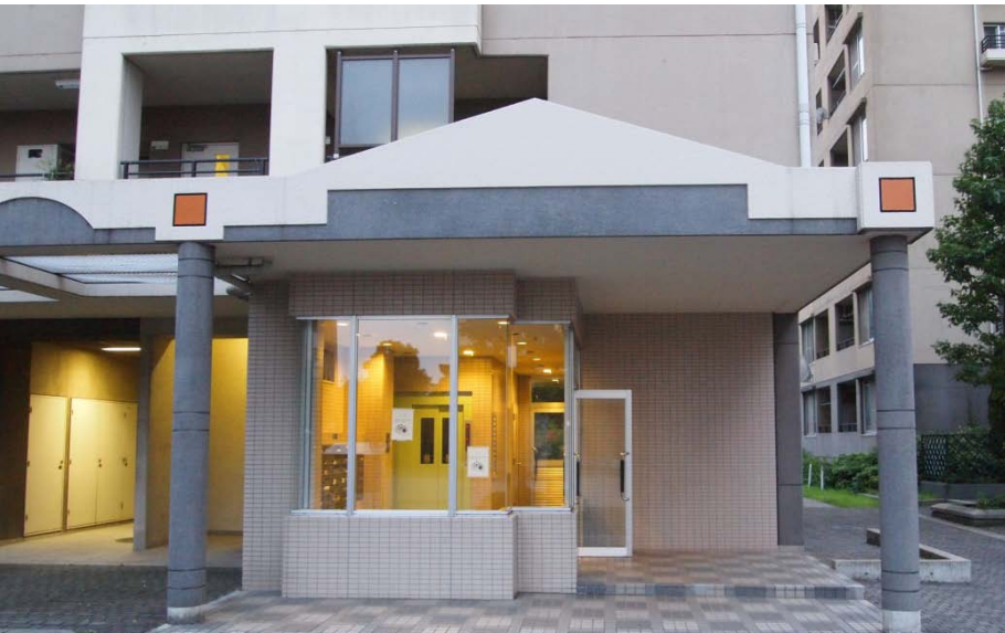
屋外から見通せるエレベータホール
