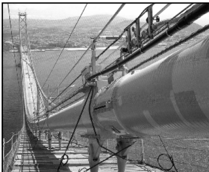
ストランドを束ねた ケーブルの完成 明石海峡大橋
