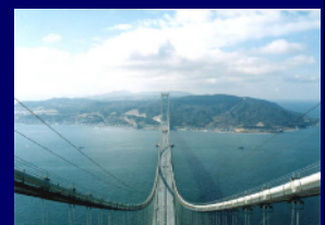
明石海峡大橋
