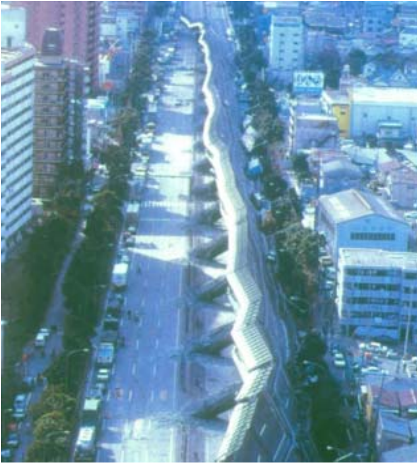
1995兵庫県南部地震：阪神高速
