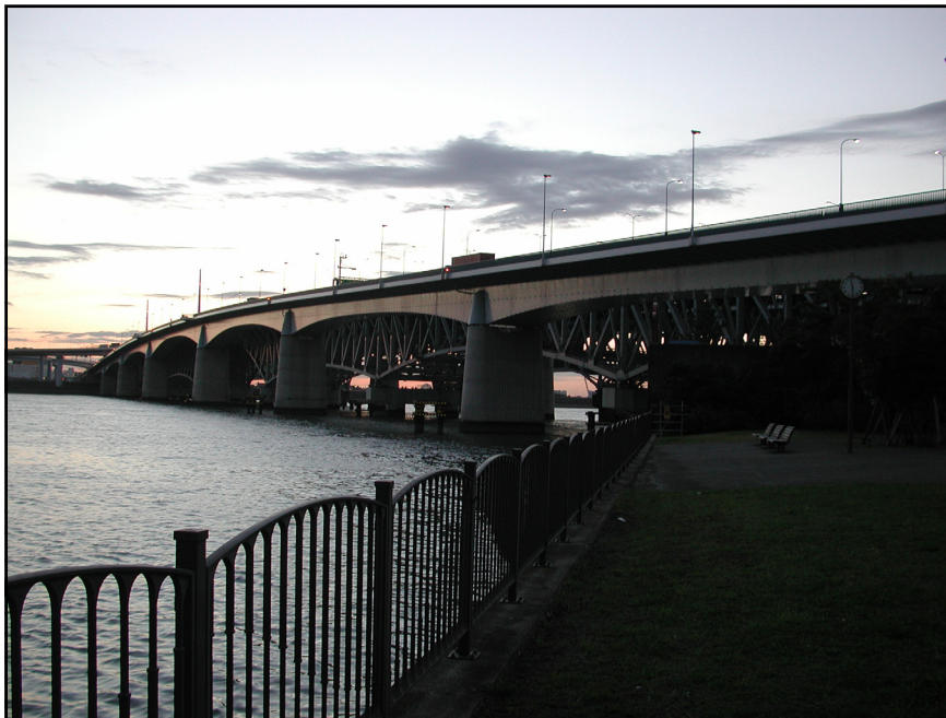
箱断面桁橋(連続梁) Box-Section
