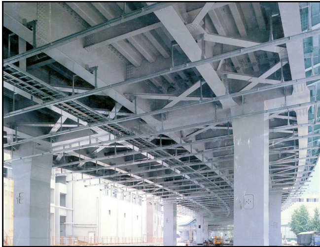
首都高速道路の高架橋 プレートガーダー橋 曲げ部材の例： 上部工の主桁，橋脚
