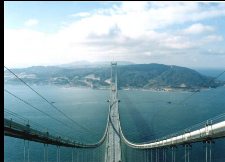
明石海峡大橋
