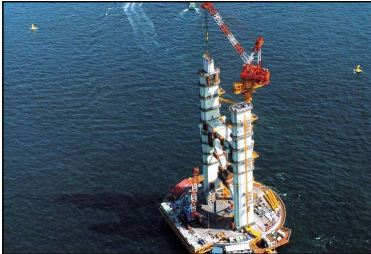
主塔(タワー)の架設
