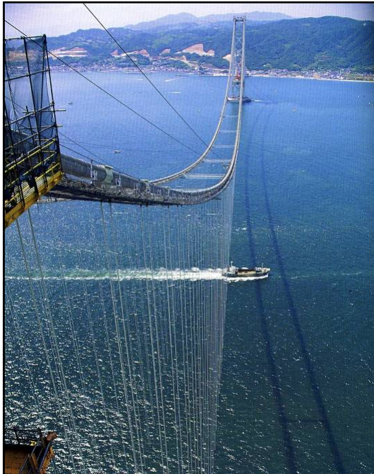
ハンガーケーブルの 設置
