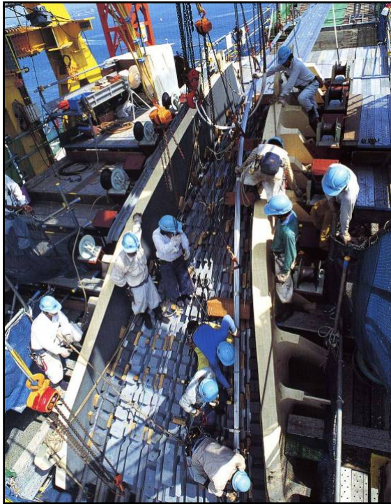
スプレーサドルへの ストランドのセット
