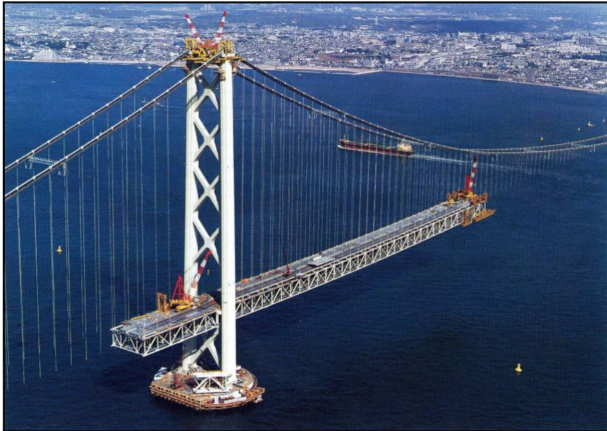
トラス補剛桁の架設
