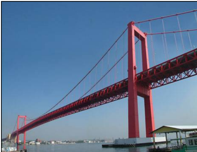
若戸大橋 北九州市 1962年 支間367m 日本で初の本格的吊橋 (ただし、ケーブルはより線)
