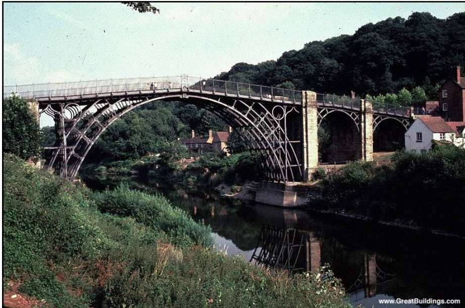
Coalbrookdale Bridge 英国 1779年 支間30.5m 最初の鉄製の橋
